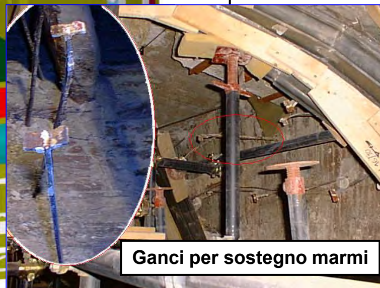
Ponteggio realizzato sotto la volta
