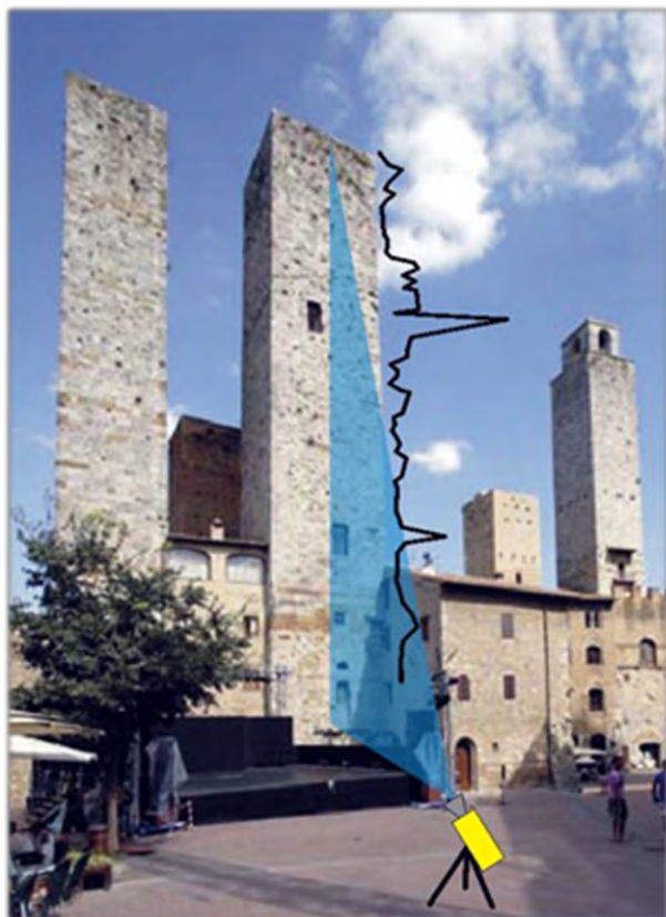
Caratterizzazione dinamica delle torri con radar interferometrico
